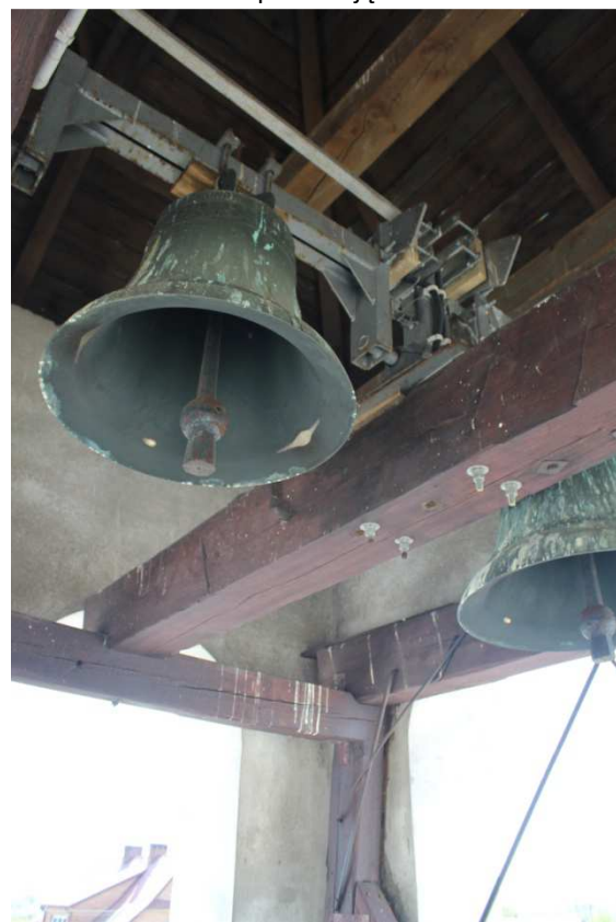
Fot.24. Widok na konstrukcję wsporczą dzwonów.
