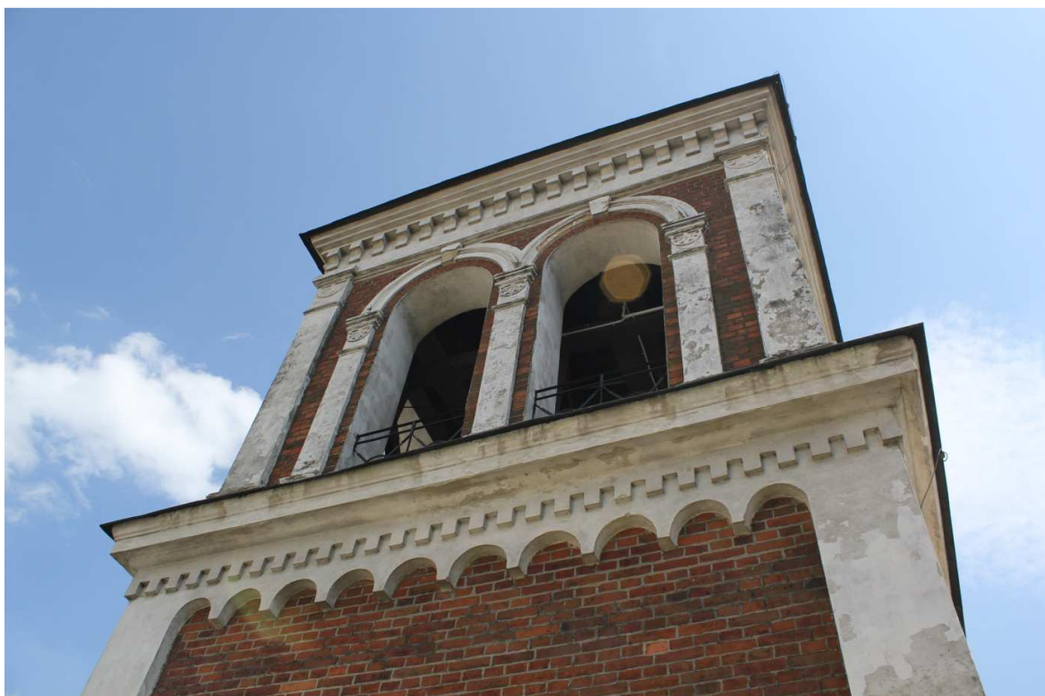
Fot.12. Widok na górną część dzwonnicy, widoczny detal arkadkowy, gzyms obwodowy, zdobienia części górnej.
