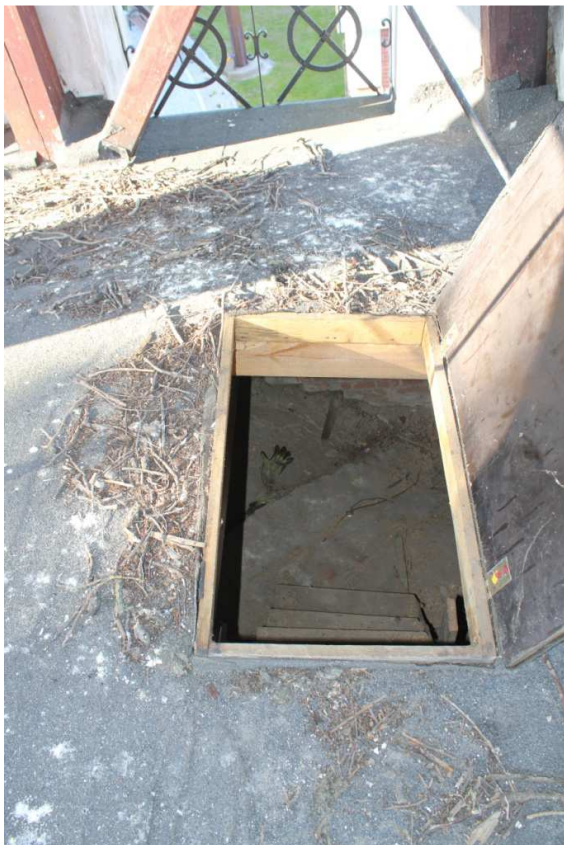
Fot.21. Drewniana kłapa wyłazowa na część tarasową.
