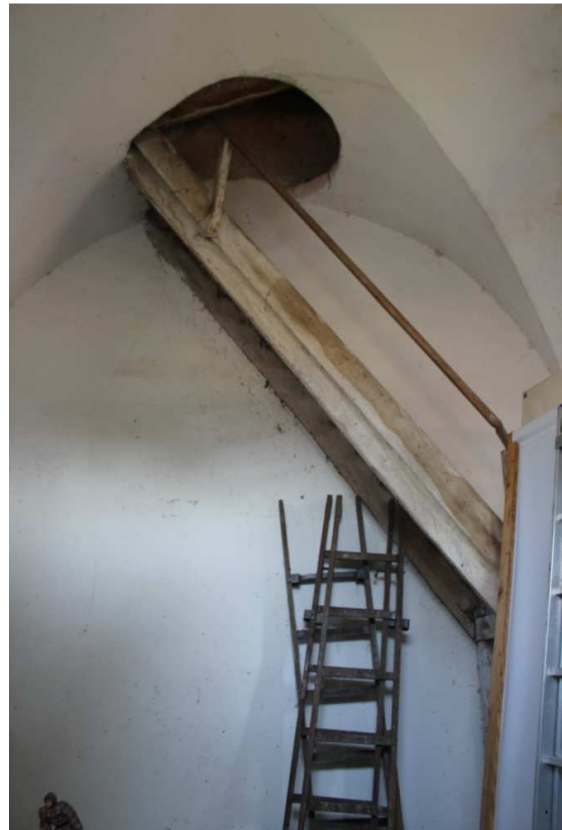
Fot.17. Drewniane schody na wangach na część tarasową, widoczny otwór w sklepieniu.
