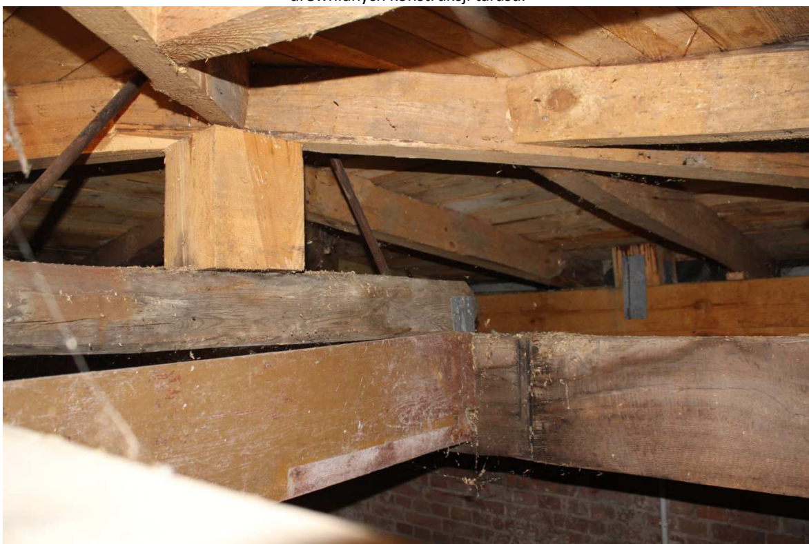
Fot.20. Przestrzeń nad sklepieniem. Widoczne stare i nowe elementy konstrukcyjne tarasu.
