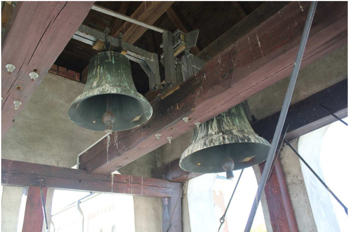
Fot.25. Widok na konstrukcję wsporcą dzwonów.
