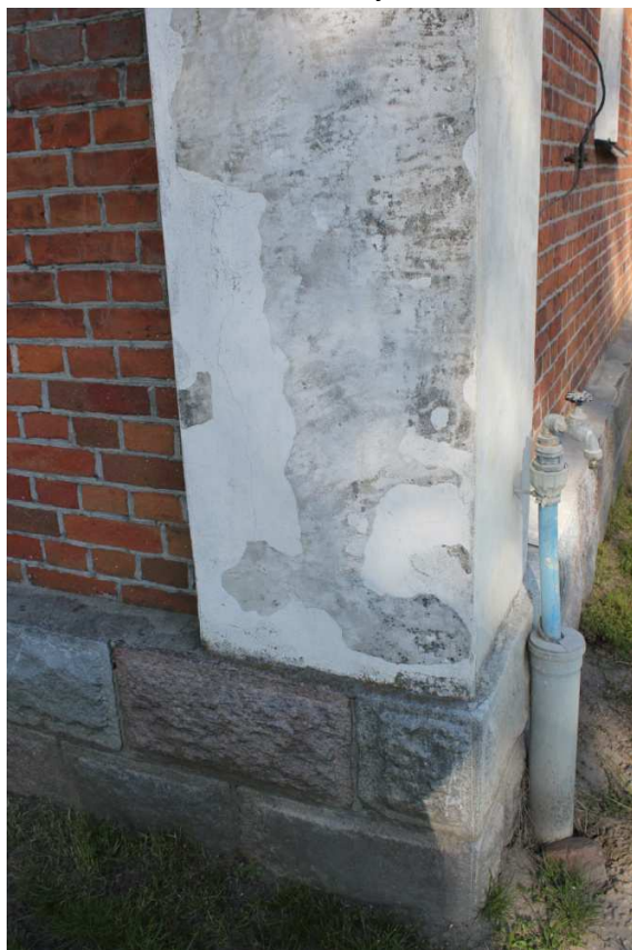
Fot.5. Widok na narożniki dzwonnicy, widoczne odspojenia tynków.
