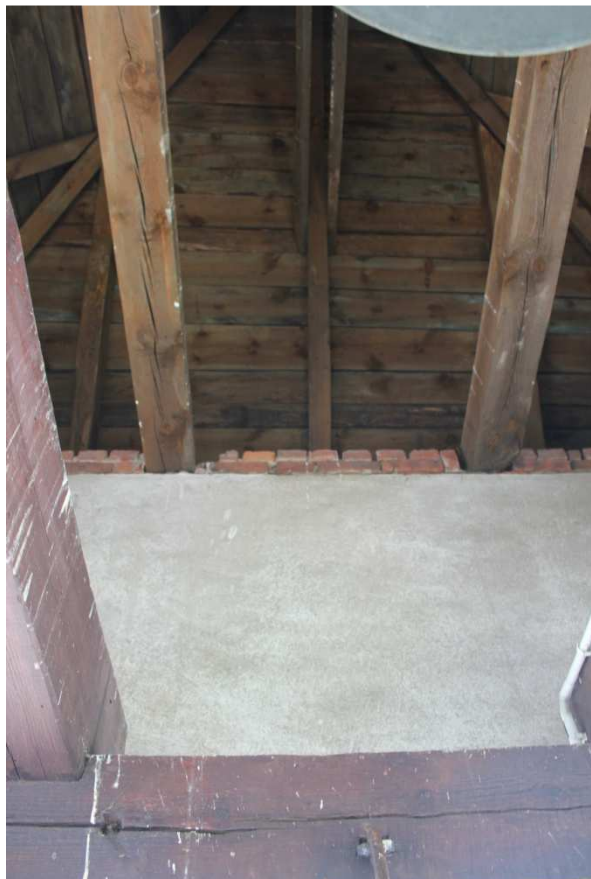
Fot.27. Widok na belki konstrukcyjne dachu głównego.
