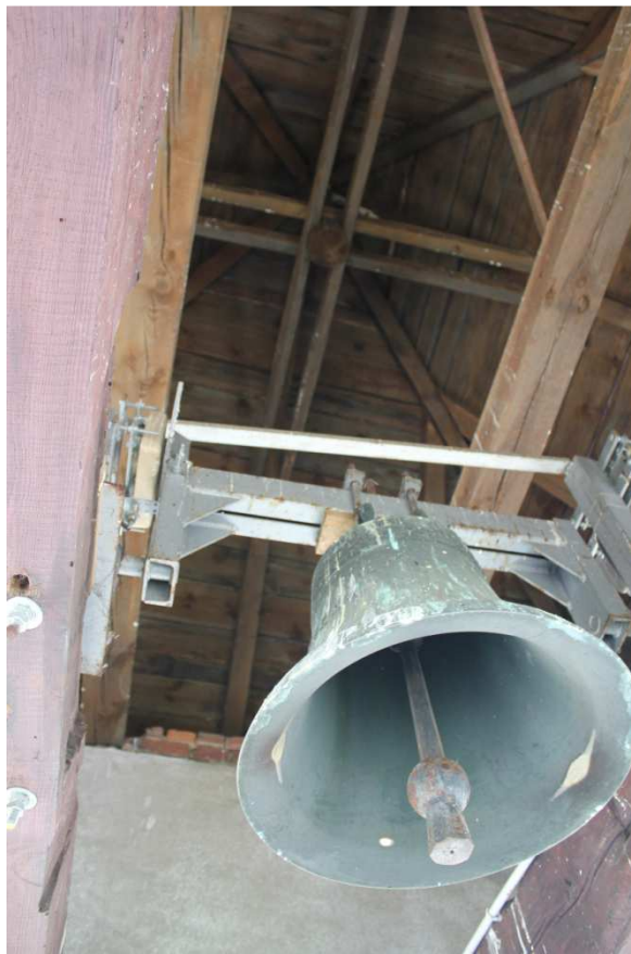
Fot.28. Widok na belki konstrukcyjne dachu głównego.
