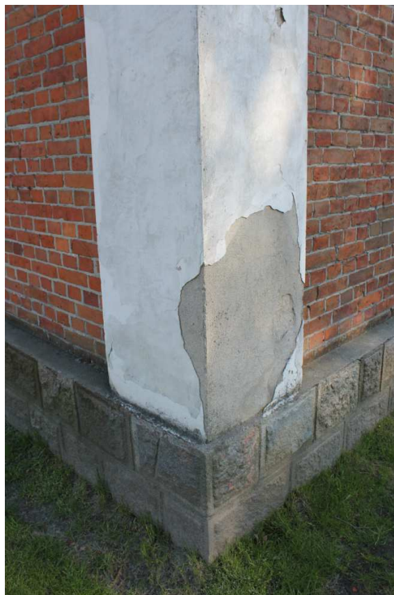
Fot.6. Widok na narożniki dzwonnicy, widoczne odspojenia tynków.
