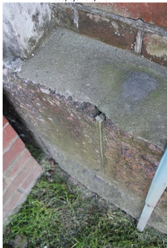
Fot.7. Widok na górną część cokołu z warstwą spadkową, cementową.
