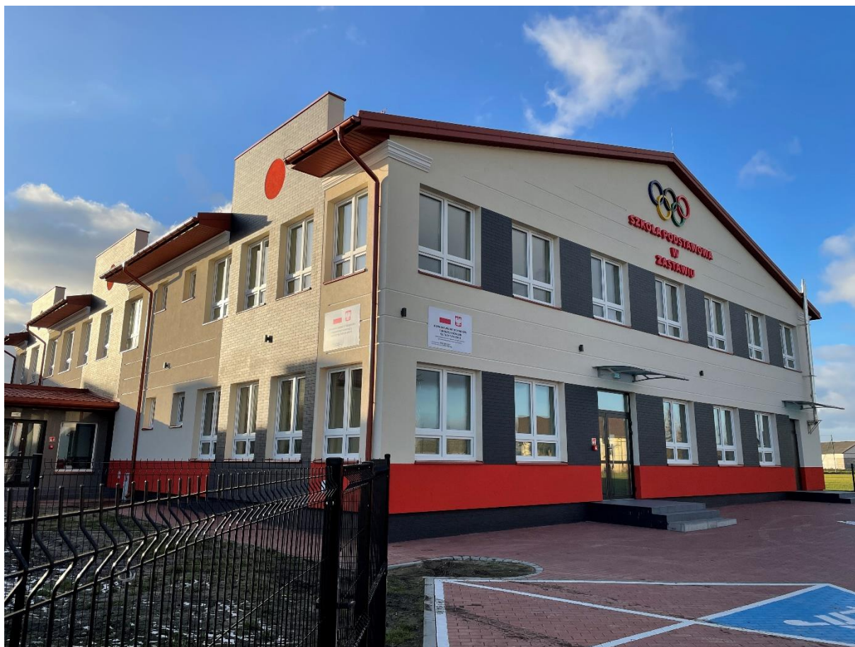
Sala gimnastyczna z zapleczem szatniowo-sanitarnym przy Szkole Podstawowej w Zastawiu.
