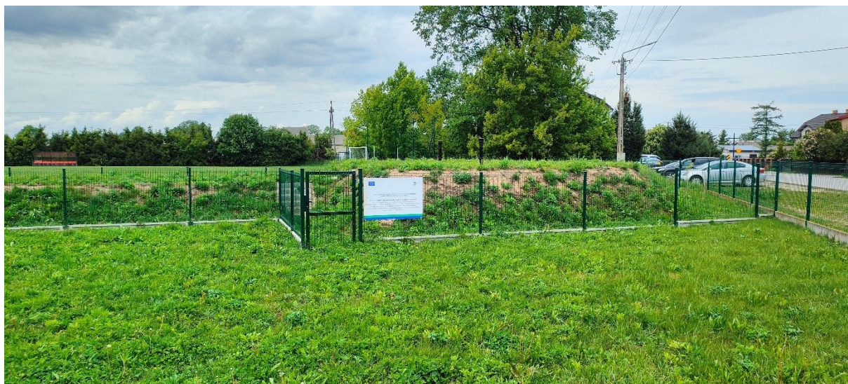
Oczyszczalnia ścieków przy Zespole Szkół w Tuchowiczu
